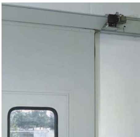
MEC 200LB – montáž na posuvných vratech
