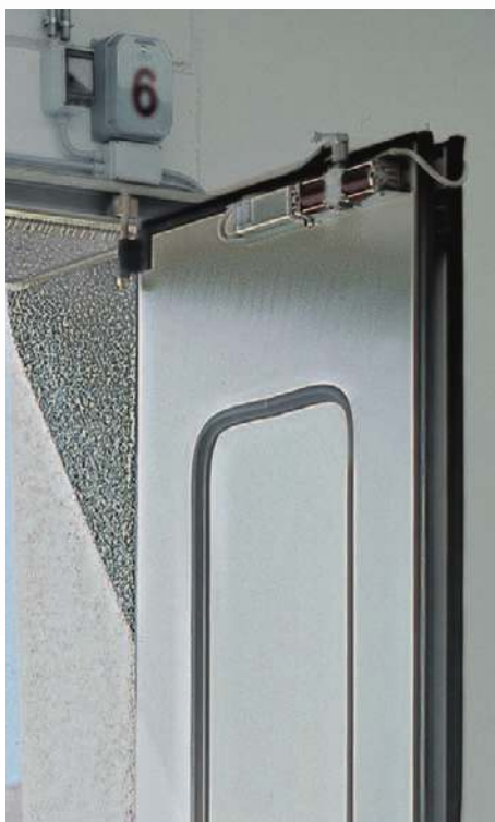
APROLI 380 LB instalovaný na skládacích vratech s maximální šířkou jednoho křídla 2 m
